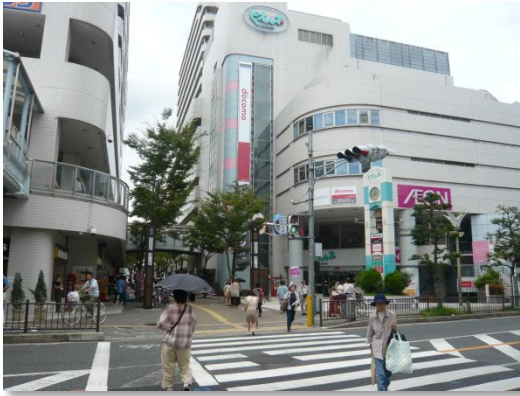
岡本町にあるピオルネ イオン、ドラッグストア、書店、衣料雑貨等の専門店 が入店している。 枚方岡本町地区第一種市街地再開発事業により建設。
