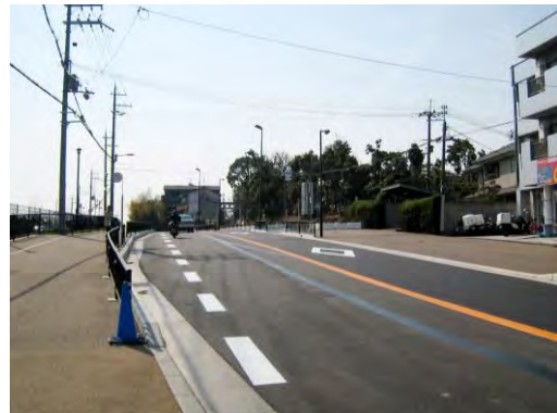
工事進行中の一般府道139号枚方茨木線
