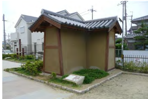
九頭神廃寺：寺域北西コーナーの築地塀表示
