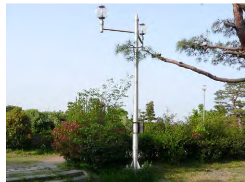
中門付近にある照明灯
