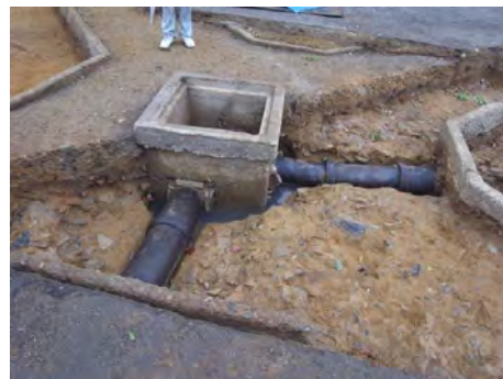
昭和7年の史跡整備で設置された 雨水枡と地中配管
