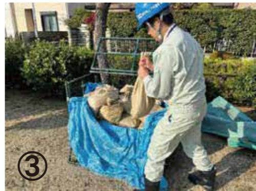
③ ◆必要な土のうを取り出します。
