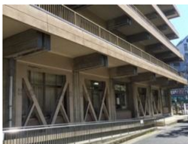
防災拠点としての耐震性の不足
