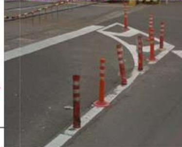
参考)区画線(導流帯)及びバパーポールの設置
