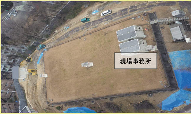
造成中（平成30年2月撮影）
