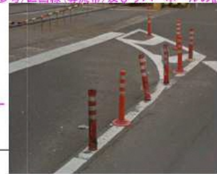
参考) 区画線(導流帯)及びラバーボールの設置
