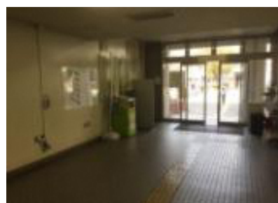
職員通用口と一般利用出入口が混在
