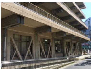
防災拠点としての耐震性の不足
