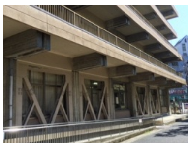
防災拠点としての耐震性の不足
