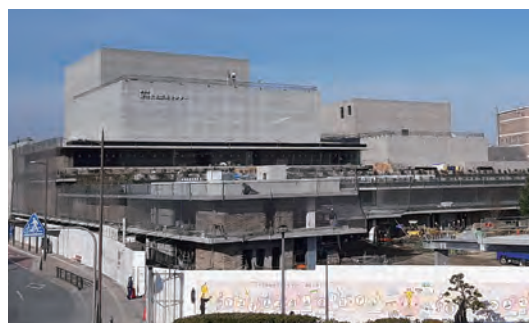
▲建設中の総合文化芸術センター
