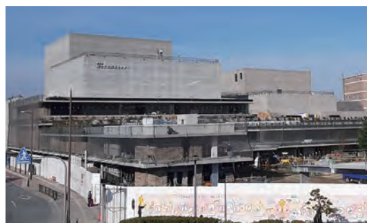
▲建設中の総合文化芸術センター
