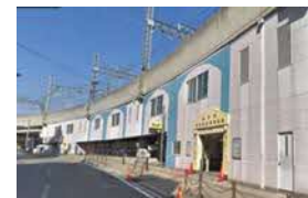
<市営自転車駐車場>
