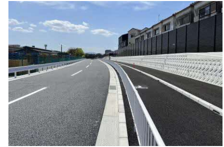
<御殿山小倉線 道路整備工事>
