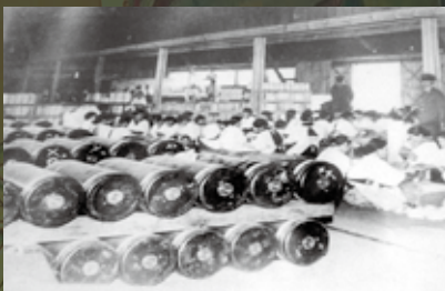
▲禁野火薬庫内部
