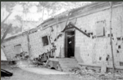
▲爆発で崩れた禁野火薬庫倉庫
