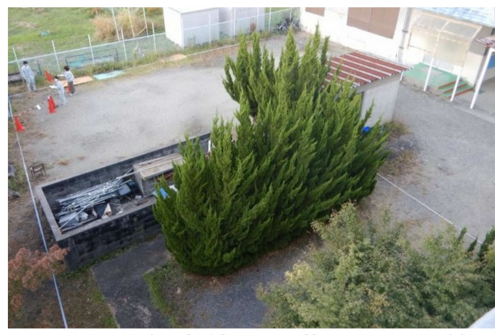
北教室棟屋外階段からの俯瞰
