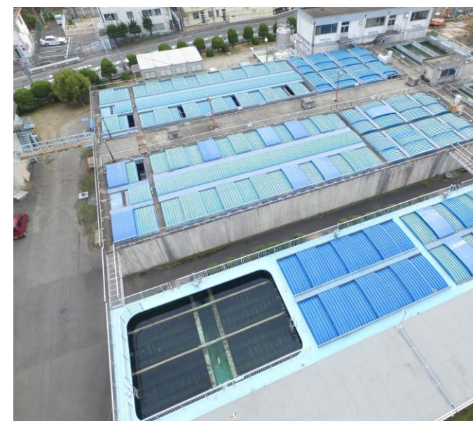
膜ろ過方式（槽浸漬型）
