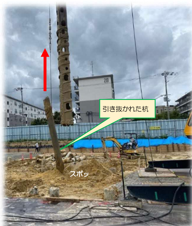
—②杭を引き抜きます—
