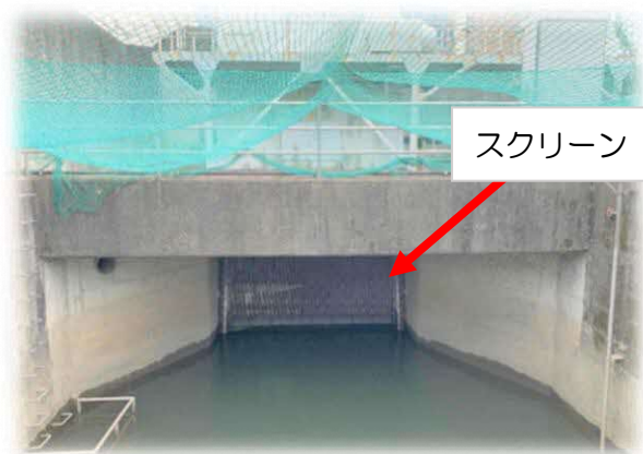
—磯島取水場の除塵井とスクリーン—
