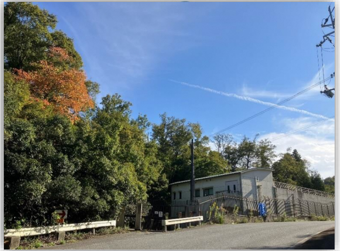
新穂谷配水場の様子 令和4年10月21日撮影 周囲の木々が徐々に色付いてきています。
