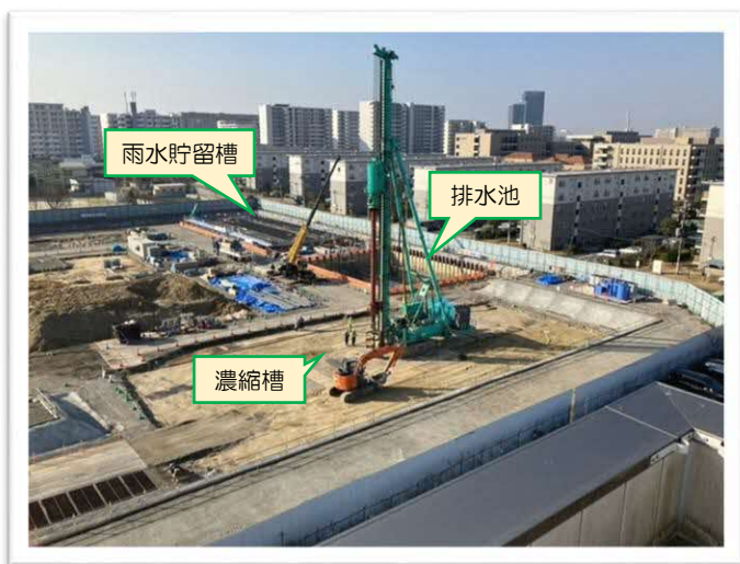
中宮浄水場更新用地 令和6年2月14日撮影
