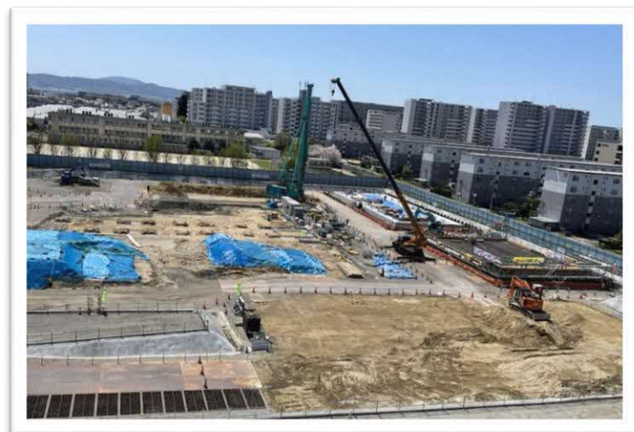
中宮浄水場更新用地 令和6年4月10日撮影
