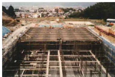
津田低区配水場（建設中）
