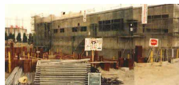
磯島取水場（建設中）
