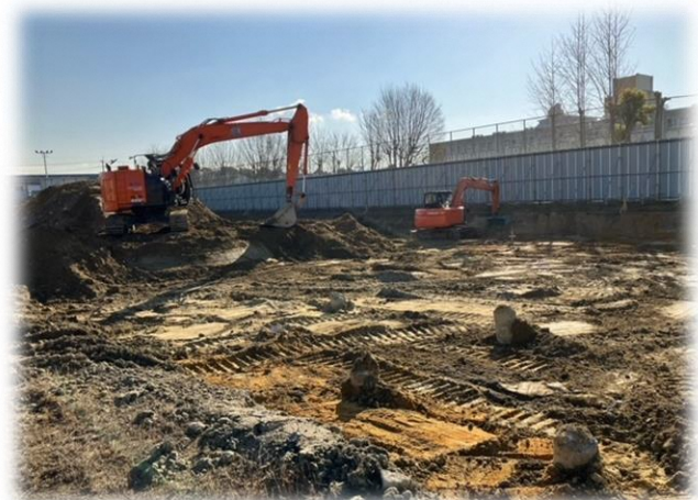
-掘削作業のようす-
