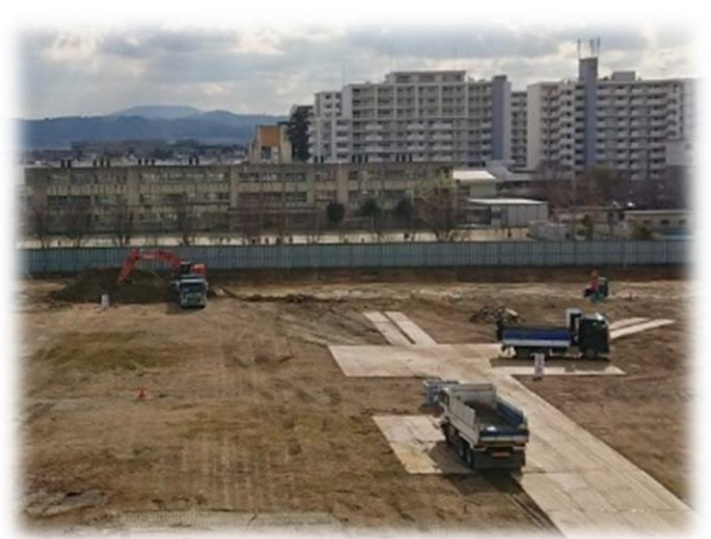
-掘削作業のようす-
