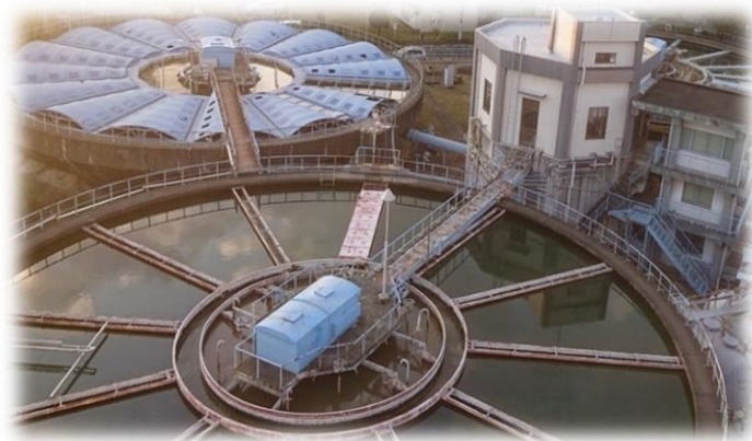
— 現在の中宮第1浄水場 急速沈殿池 —
