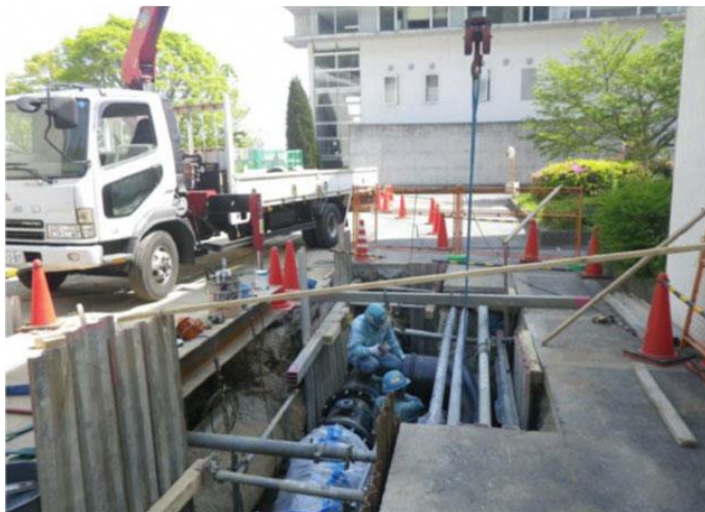
既設導水管接続工事イメージ写真
