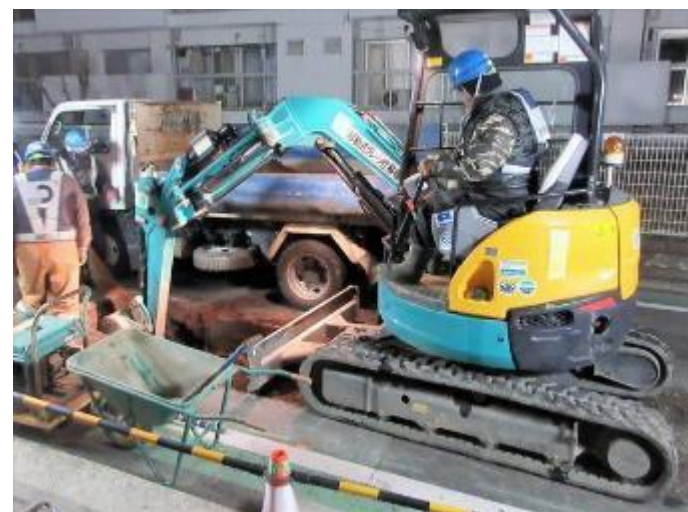
道路部配管工事イメージ写真
