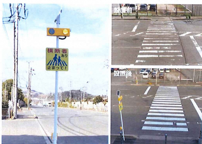
大型車の通行量が多く、照明が無いため夜間は歩行者を確認しにくい道路。近くの民間会社が出資してくださり、広島県警、福山市役所の立会いの下で設置許可をいただき、2021年12月に設置となりました。
